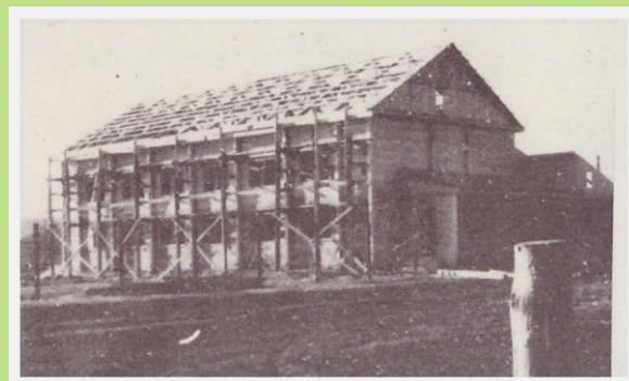
Идет строительство Дома спорта
